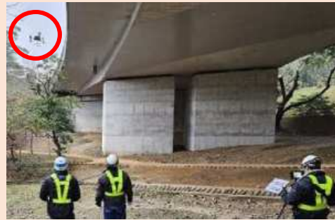
ドローンによる点検
