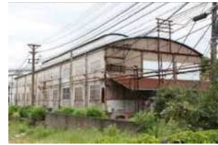
官営八幡製鐵所 旧鍛冶工場 【明治 33 年（1900）建設・北九州】
