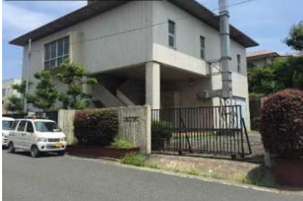
②中ノ浜ポンプ場
