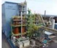
12m 3 小規模試験高炉(水素還元)
