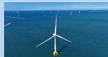
洋上風力(提供:ひびきwindエネルギー(株))
