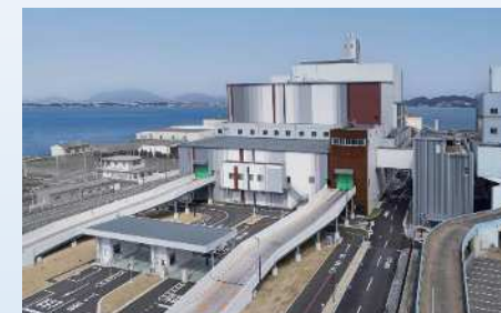
ごみ焼却工場(日明工場)
