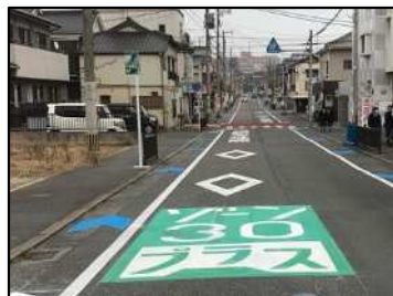
ゾーン30プラス看板・路面表示
