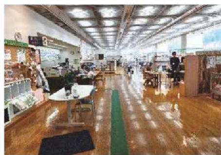
改修前の床面
