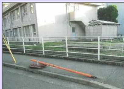
カーブミラーの倒壊
