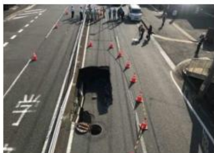
下水道管渠破損による道路陥没
