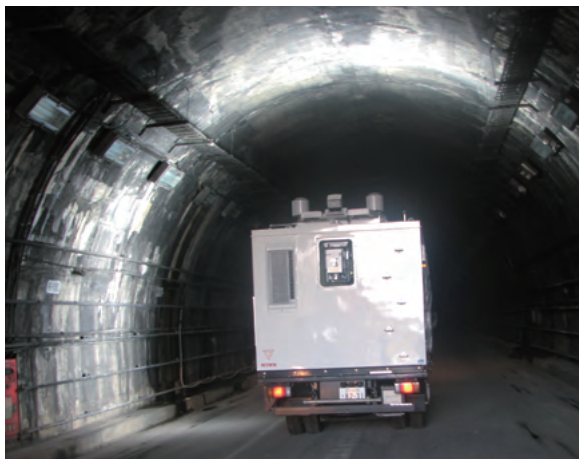
道路トンネルを通常走行しながら壁面を計測するMIMM
