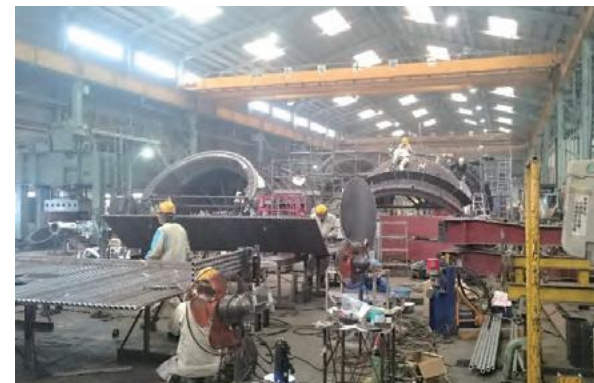
OG設備製作状況
