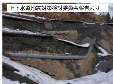
令和6年能登半島地震における水道送水管の被災
