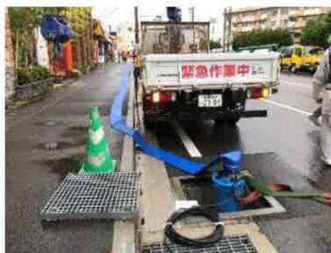
仮設排水ポンプの設置（豪雨対策）
