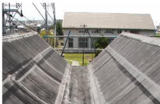
ポンプ棟屋上防水前
