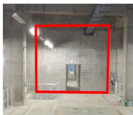
補強後（中空部に耐震壁を設置）
