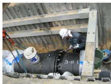
耐震管布設状況
