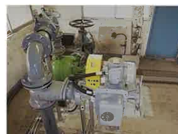
ポンプ設備更新後
