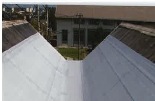
ポンプ棟屋上防水後
