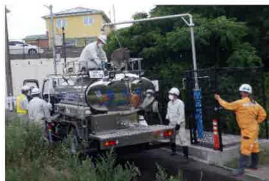
給水塔から給水車への補給状況
