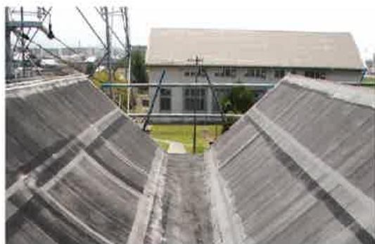
ポンプ棟屋上防水前
