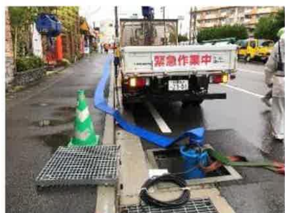
仮設排水ポンプの設置（豪雨対策）
