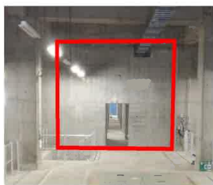
補強後（中空部に耐震壁を設置）
