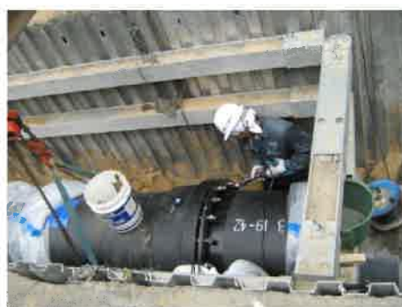
耐震管布設状況
