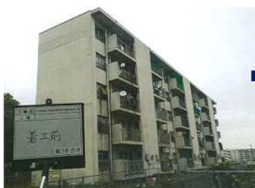
〈外壁改修〉(改修前)
