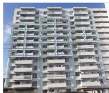
〈耐震改修〉(改修後)
