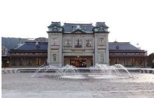
門司港駅 (国指定重要文化財【建造物】)
