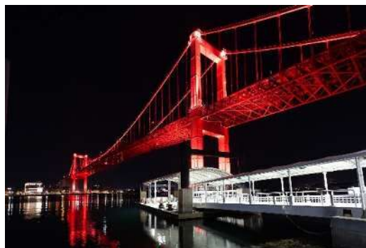
若戸大橋・若戸トンネルの無料化
