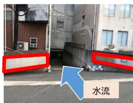
止水板の設置
