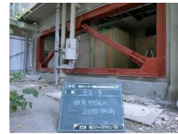
看護師宿舍棟耐震補強工事
