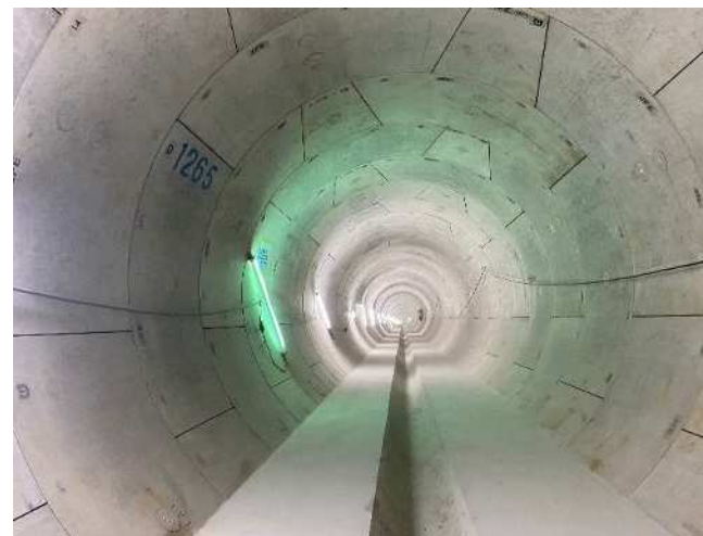
雨水貯留管 〔昭和町 貯留管 施工例〕
