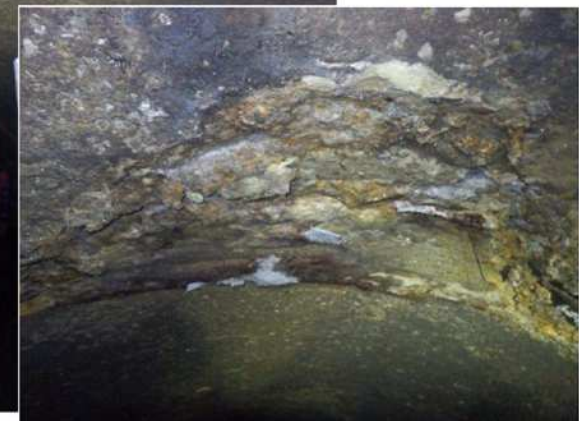
鉄筋コンクリートの骨材露出
