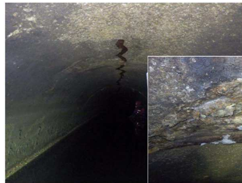
鉄筋コンクリートの骨材露出
