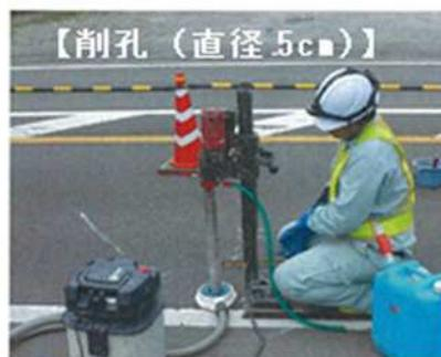
削孔による空洞の確認イメージ
