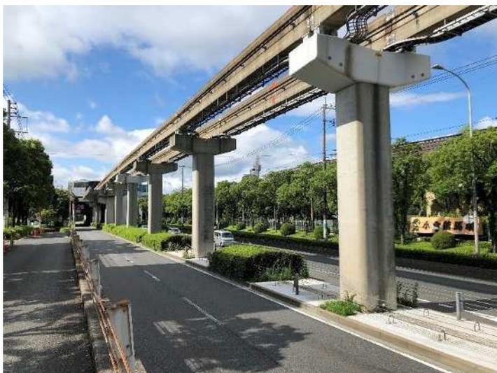
鋼軌道桁・鋼支柱
