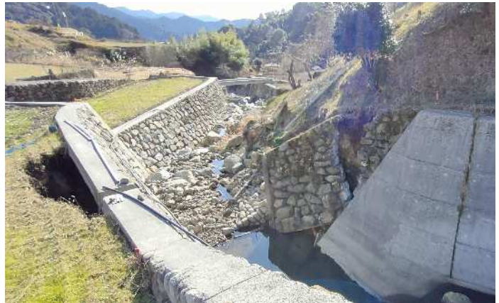
棚田に盛土して仮設道路設置する現場
