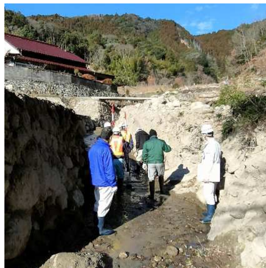
埋そく土砂を撤去後、被災状況認中
