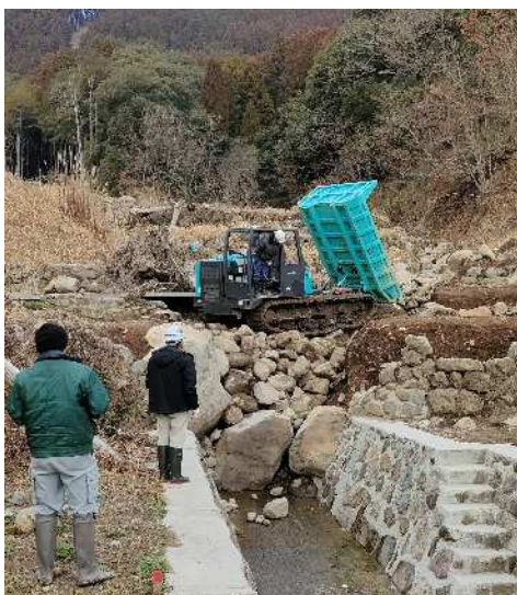
埋そく土砂を撤去中
