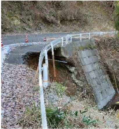
写真手前側から仮設道路を設置する現場
