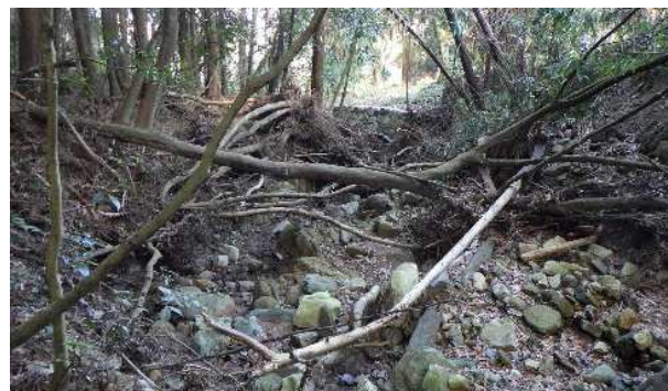
写真－３ 土砂や流木が堆積した河道
