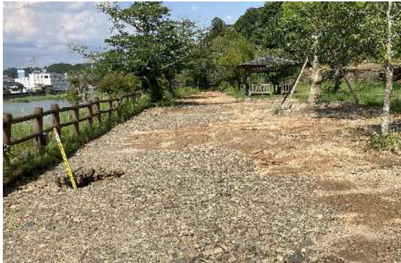
令和4年度・応急復旧後
