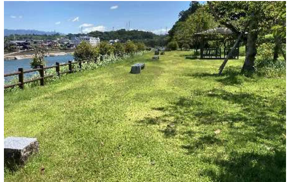
令和5年度・仕上げ工事完了後
