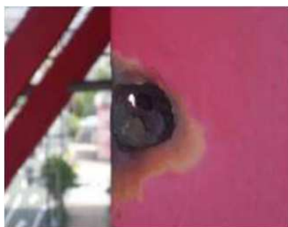
▲若戸大橋の損傷状況(腐食)
