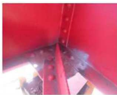
▲若戸大橋の損傷状況(腐食)
