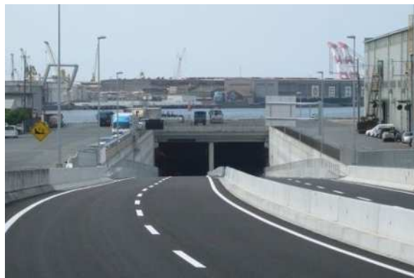
▲若戸トンネル(戸畑側通行口)
