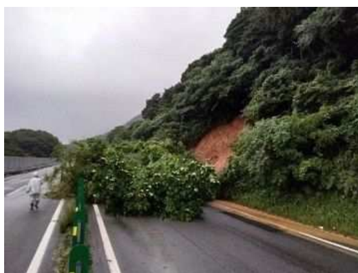
▲ 平成30年7月豪雨災害 (北九州都市高速道路)
