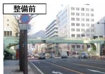
▲歩道橋撤去(小文字歩道橋)
