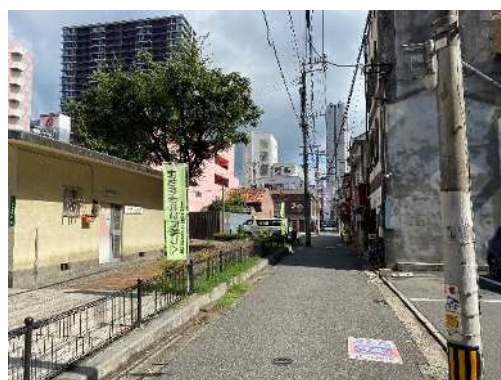
写真.4 歩道がない道路（地上機器の設置困難）
