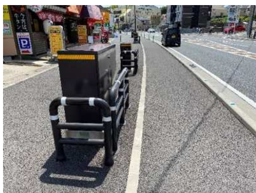
写真.3 幅員が広い歩道（地上機器の設置状況）
