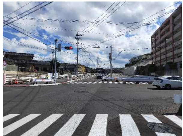
▲12号線(浅川工区)【整備中】(八幡西区)
