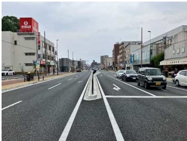
▲国道199号(日吉台光明線)【整備中】(八幡西区)
