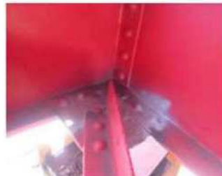
▲若戸大橋の損傷状況(腐食)
