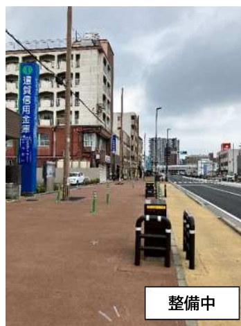
▲道路の無電柱化(折尾地区)
