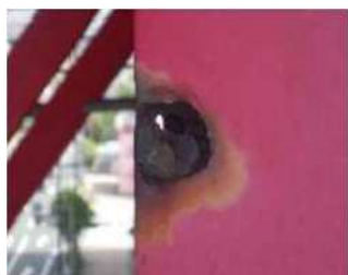
▲若戸大橋の損傷状況(腐食)
