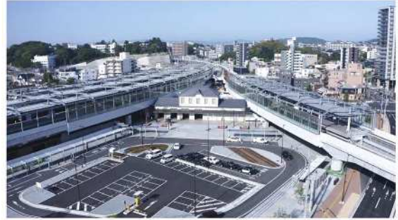
▲折尾駅北側駅前広場
