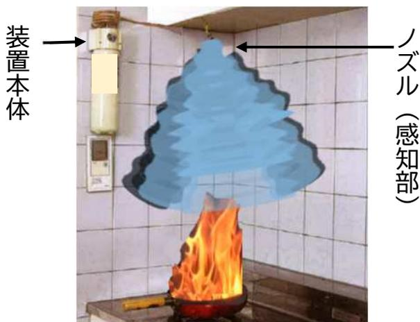
簡易型自動消火装置作動時のイメージ
