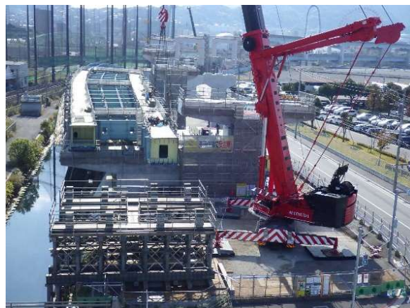
〈戸畑枝光線(牧山枝光間)橋梁上部工架設工事(29-3)〉
