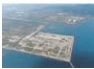
響灘地区港湾(整備実施中)
