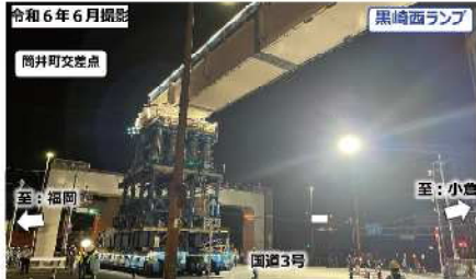
▲架設時の状況 (簡井町交差点を跨ぐ橋梁)
