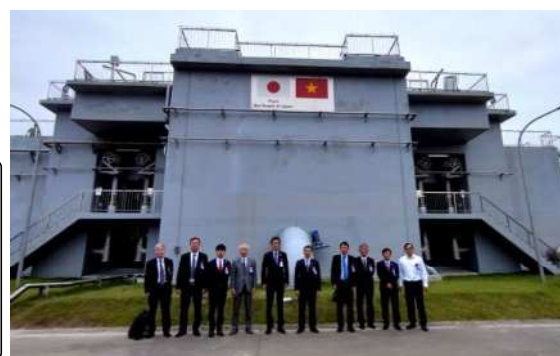
アンズオン浄水場U-BCF設備
