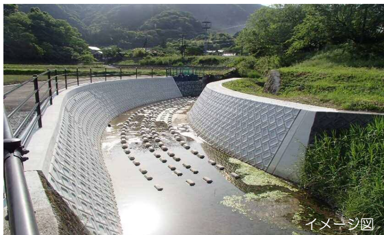
【河川整備：護岸工事等】
