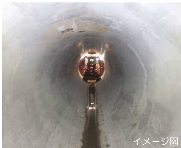
【上下水道整備：浸水対策整備等】
