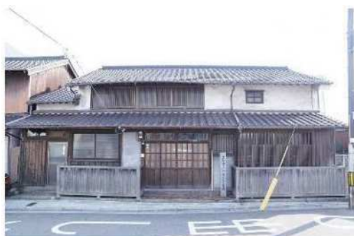
正面外観（北から）
