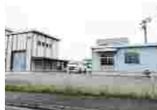
グリーンLPGガス直接接続技術開発実証研究施設
