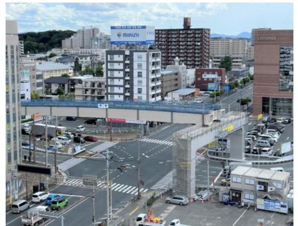
▲黒崎西ランプ（筒井町交差点）の状況（R6.7）
