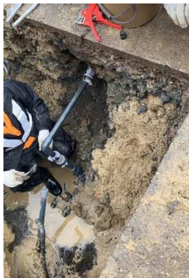
⑤修繕状況 漏水している給水管の部分取替
