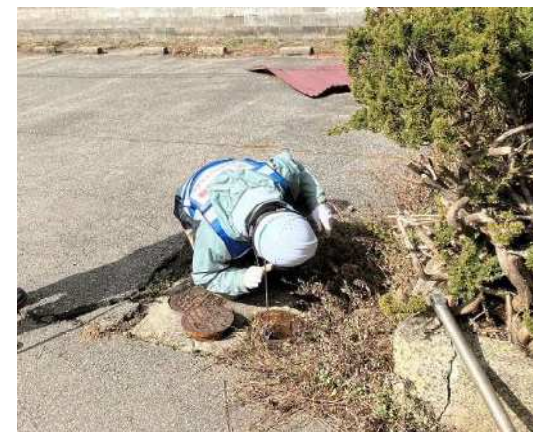
③漏水調査の状況 漏水音を確認する器具(音聴棒)を直接 水道管に当てて漏水調査
