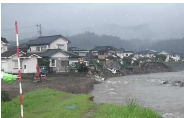
河岸侵食による家屋の倒壊(花月川)
