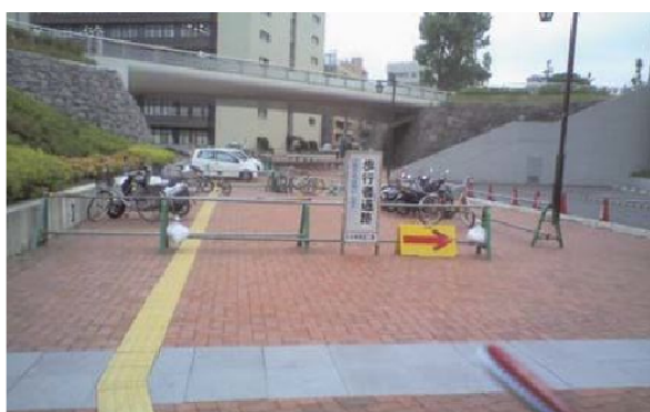
工事中のバリケードで誘導用ブロックが行き止まりに！
