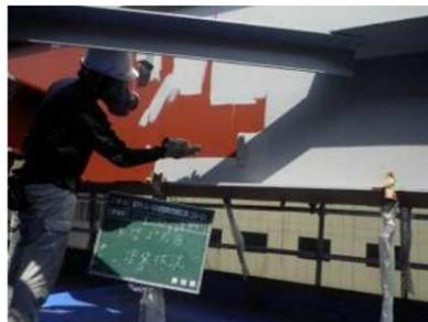
軌道桁(鋼)の再塗装
