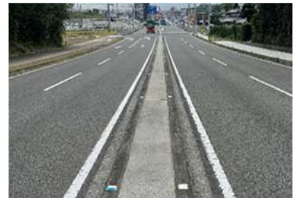
コンクリート舗装化 （施工後3年時点）
