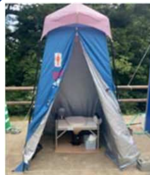
災害用マンホールトイレ
