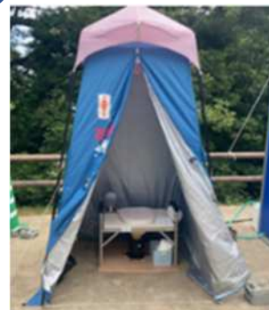
災害用マンホールトイレ
