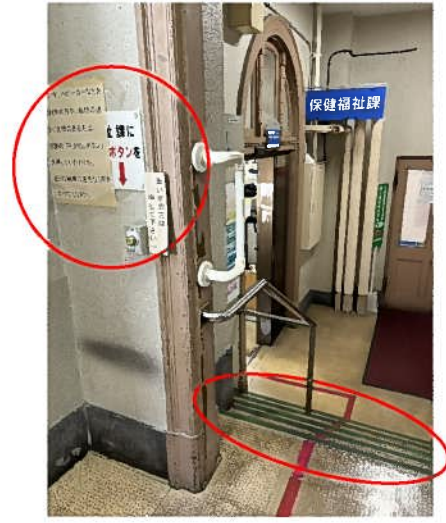
廊下の途中に階段 (車椅子、ベビーカー等の方の移動が困難)
