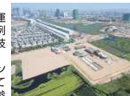
カンボジア下水処理場の建設状況
