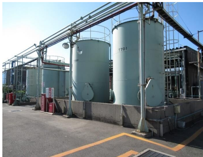
既存 燃料化施設①
